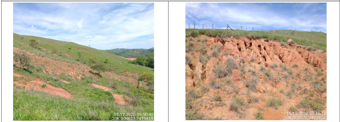
Foto 01 Vista geral das feições erosivas. Foto 02 Erosões superficiais com ravinas.
