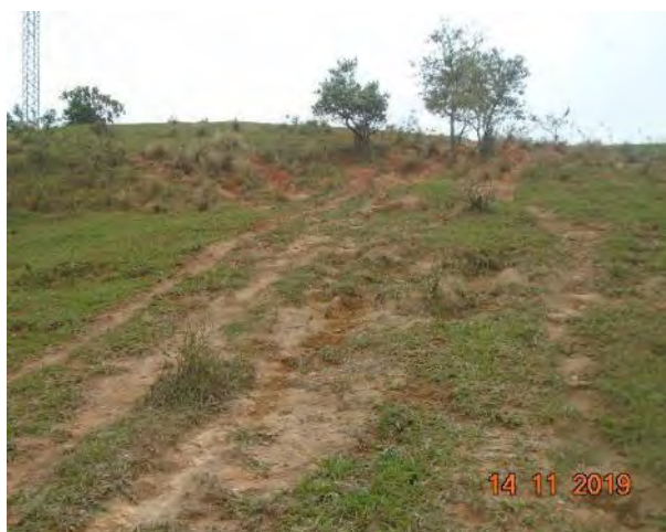
Foto 19- Vista do processo erosivo com formação de sulcos.
