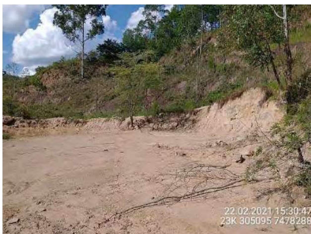
Foto 5 – Registro da utilização de máquinas no local. (22/02/2021).
