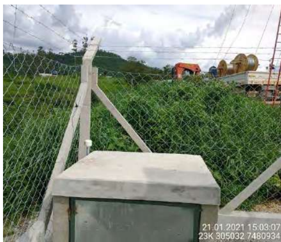
Foto 1 – Caminhão munck próximo a ES-BP. (Data: 21/01/2021).
