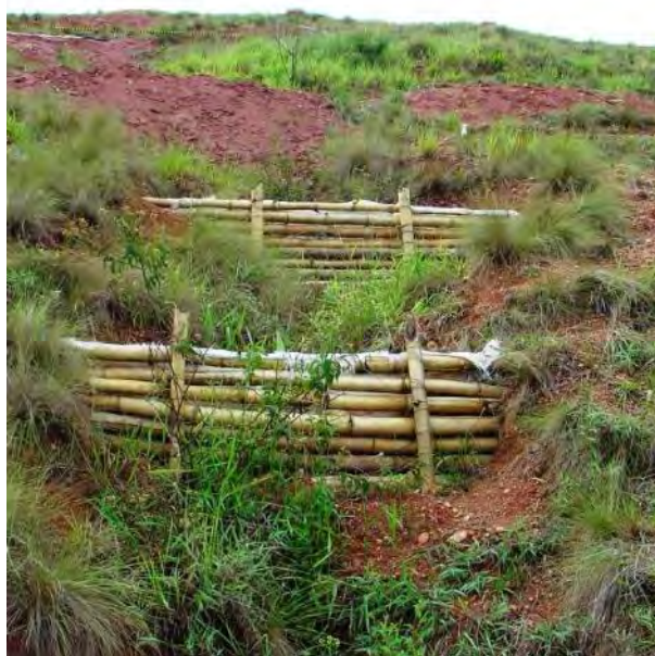
Figura 9 – Exemplo de paliçada com bambu. Fonte: www.embrapa.br .
