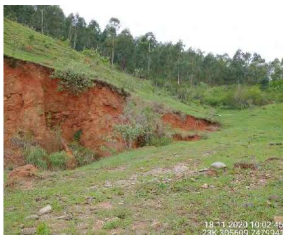
Foto 01 Vista das feições erosivas no talude.
