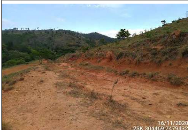
Foto 01 Vista geral da feições erosivas.
