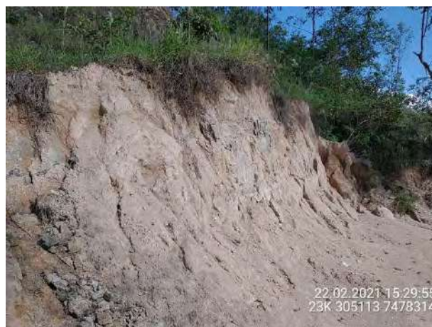
Foto 6 – Talude com a rocha exposta após a extração de material. (22/02/2021).
