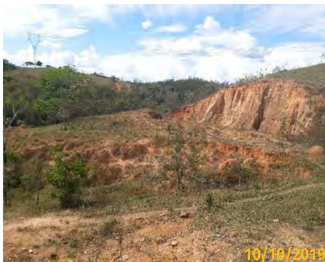
Foto 14- Vista geral da voçoroca.
