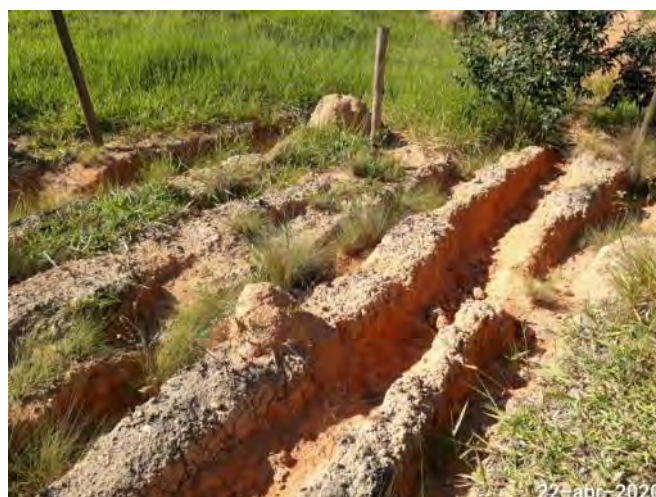
Foto 20- Panorama dos de sulcos erosivos formados pela concentração do escoamento.
