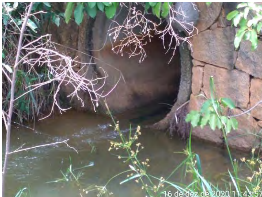
Foto 01: Ponto P07, na saída da barragem particular, vista da tubulação com baixo fluxo de água.
