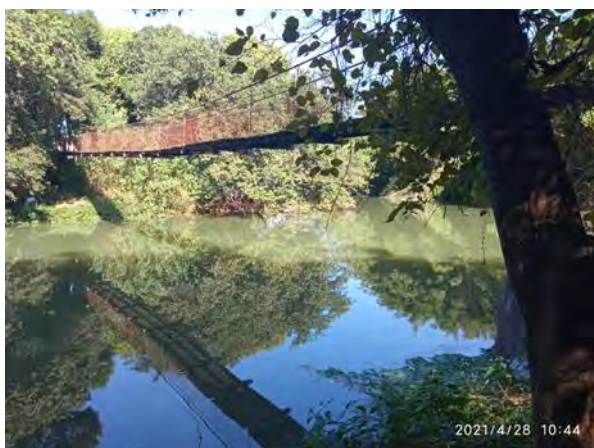
Foto 5 – Ponte de coleta de água e sedimentos no P06. (Data: 28/04/2021).
