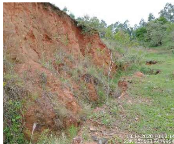
Foto 02 Detalhe do processo erosivo.
